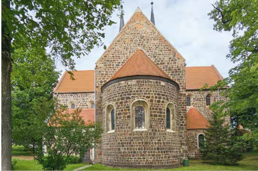
Kirche St. Nicolai, Ostansicht
